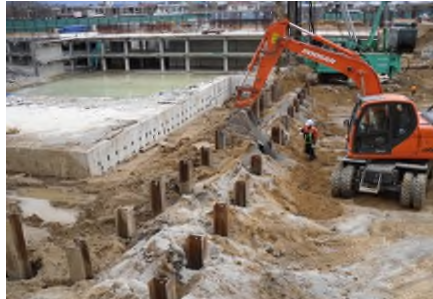
전.후열 말뚝 설치
