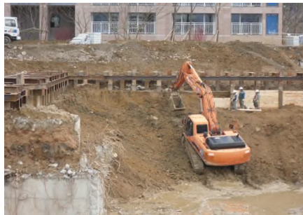
굴착 및 토류판 설치
