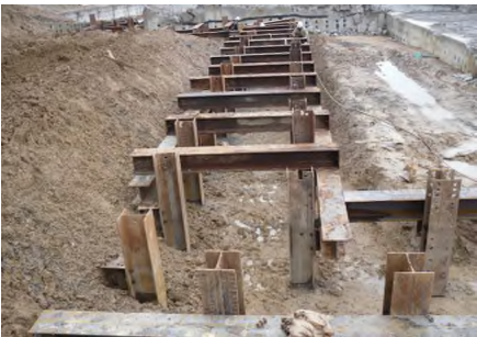
수평 연결재 설치
