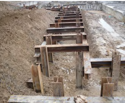
수평 연결재 설치
