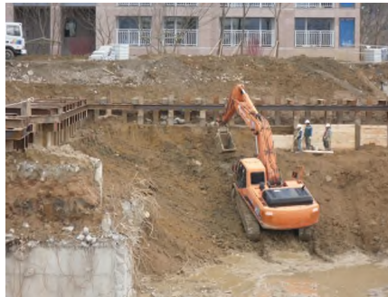
굴착 및 토류판 설치
