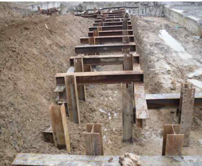
수평 연결재 설치
